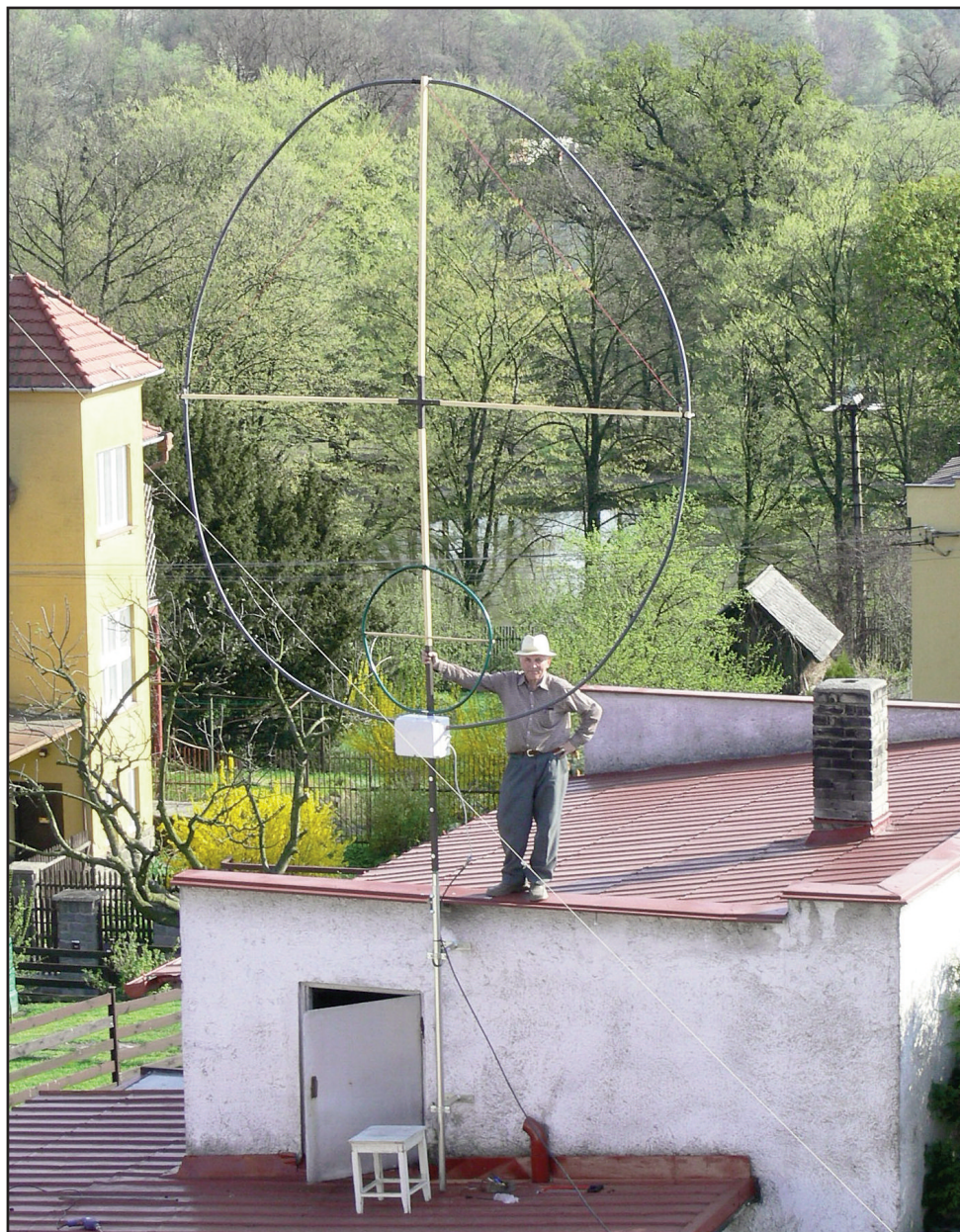
Obr.1: Někdy možnosti vybízí k realizaci větších projektů: MLA160 m, cca r. 2009 konstrukce OK2ER v QTH Klimkovice. Tato MLA byla testována také na HHRR OK2RZ, obr. 3. Při vichřici, která brala střechy a lámala stromy, MLA nevydržela - obr. 2. Později, kolem r. 2012 tuto konstrukci nahradila MLA-B – obr. 4, 5
