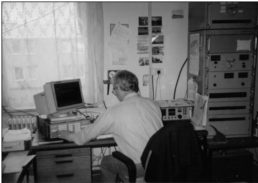
Pobřežní stanice České námořní plavby OLP v Praze, u stroje Standa OK1FCA. Na stole jsou přijímače DEBEG, vpravo ve stojanu vysílač Elektromekano. Odsud se nikdy na 500 kHz nevysílalo
